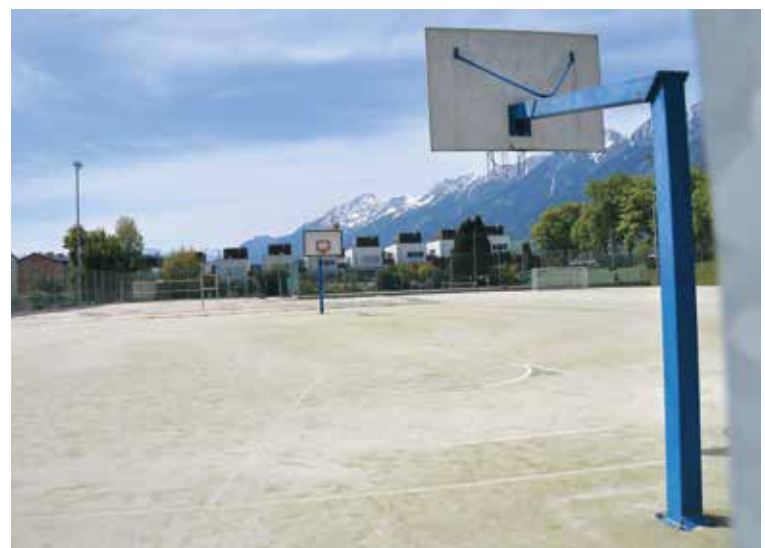
Nun soll ein Konzept für die Sanierung der alten Sportanlage ausgearbeitet werden.
